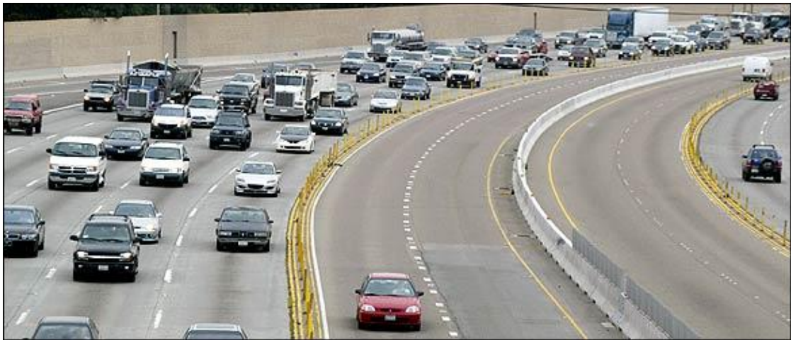
1. ábra: Az úgynevezett "toll lane"
