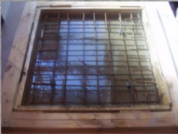
Acél armatúra elhelyezése a zsaluzatban (előzetes zsaluolaj kikenés)
