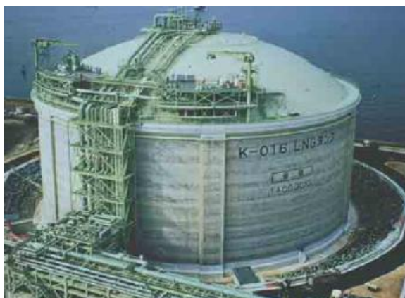
3.2. kép: Szabadtéri, feszített betontartály, Osaka Gas, Japán
