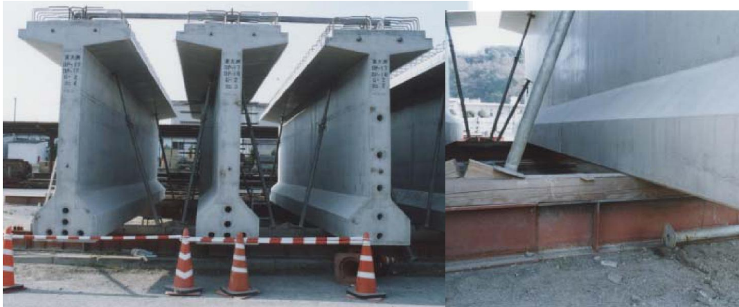
3.8. kép: Előregyártott vasbeton gerendák öntömörödő betonból
